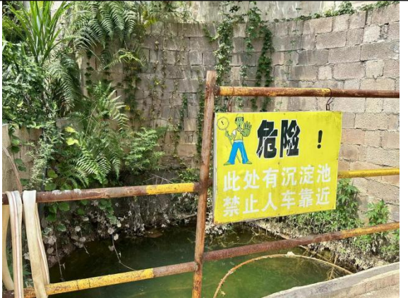
项目沉淀池 2 现状
