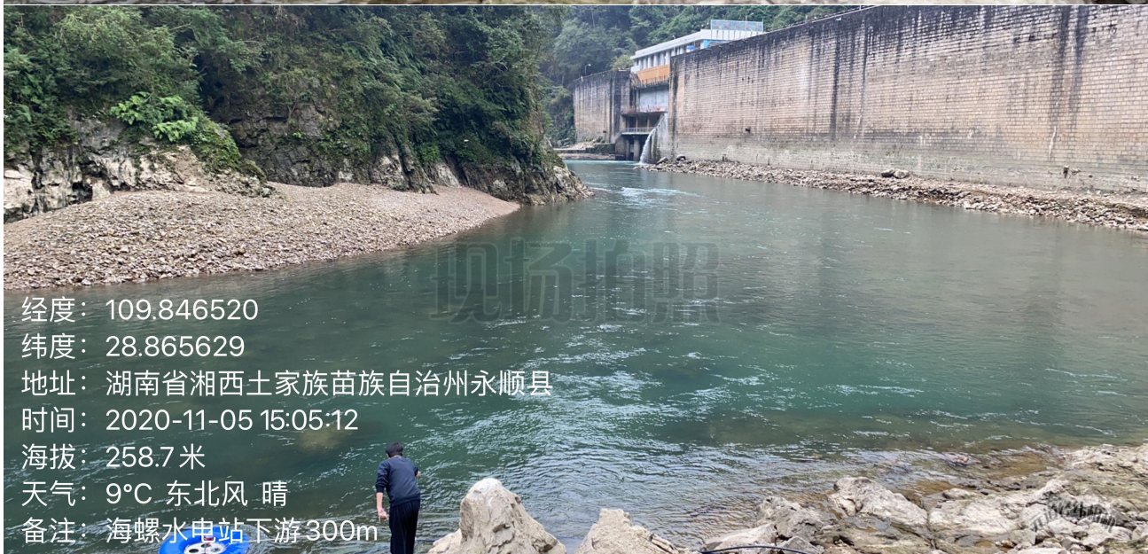
海螺水电站坝下游 300m 现场监测断面
